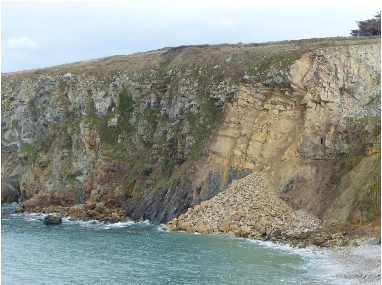
Eboulement à Porzh Korven © S. Coat RNR 08/03/2024
